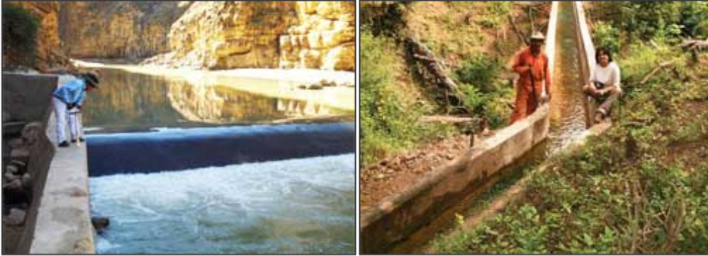
Foto izquierda. Captación de agua para riego.
