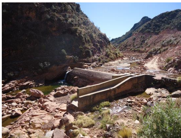
Construcción de sistema de riego.
