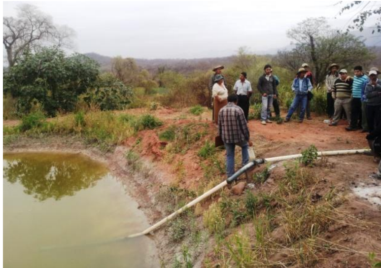
Reservorio impermeabilizado con bentonita. Villa Montes - Tarija
