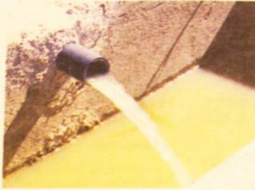
Las tuberías llevan el líquido a bebederos.
