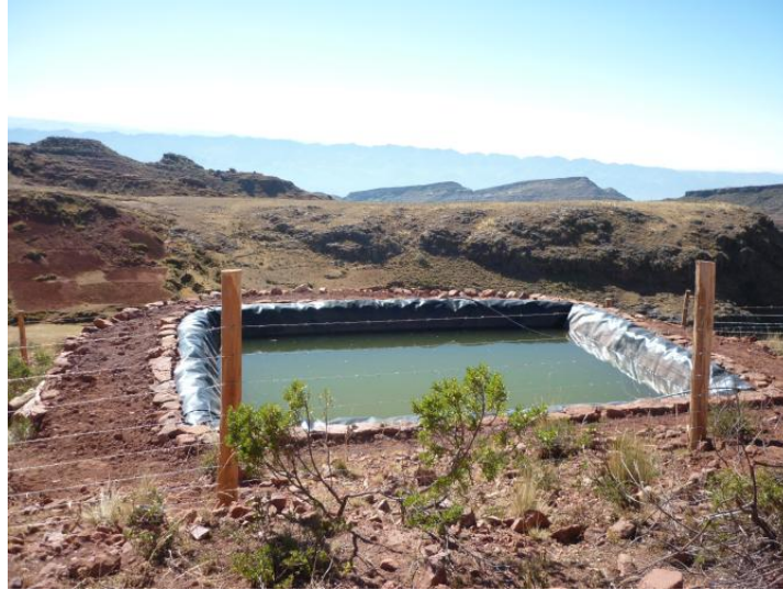
Sistema de microriego familiar de los Proyectos Integrales de "Cosecha de Agua" (PICAs) en el Municipio de Toro Toro
