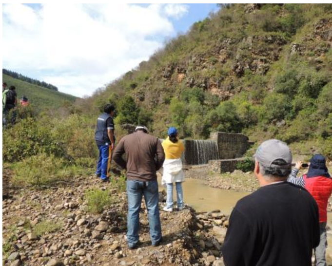
Dique de contención para el control de arrastres de sedimentos. Recorrido de campo, 3er módulo, Cuenca Escaleras – Chuquisaca.
