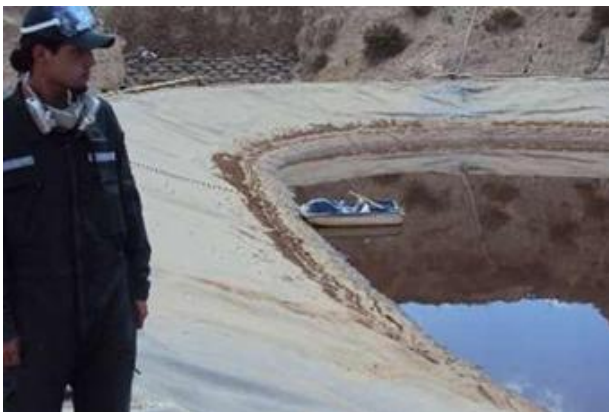
Una de las piscinas de tratamiento del líquido lixiviado para obtener agua de riego.
