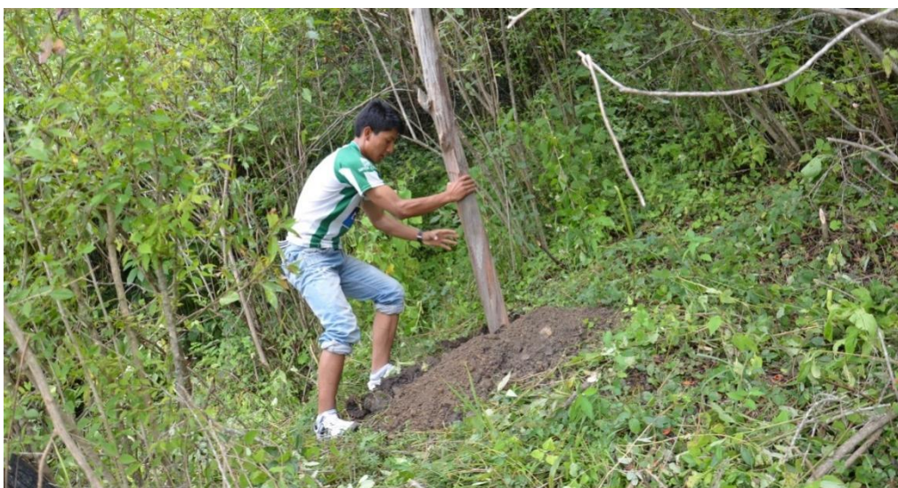
Un beneficiario trabaja en el cerramiento de una fuente de agua, Villa Serrano – Chuquisaca.
