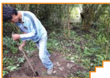
◀ Trabajos para cercar áreas que poseen manantiales de agua (Villa Serrano, Chuquisaca)
