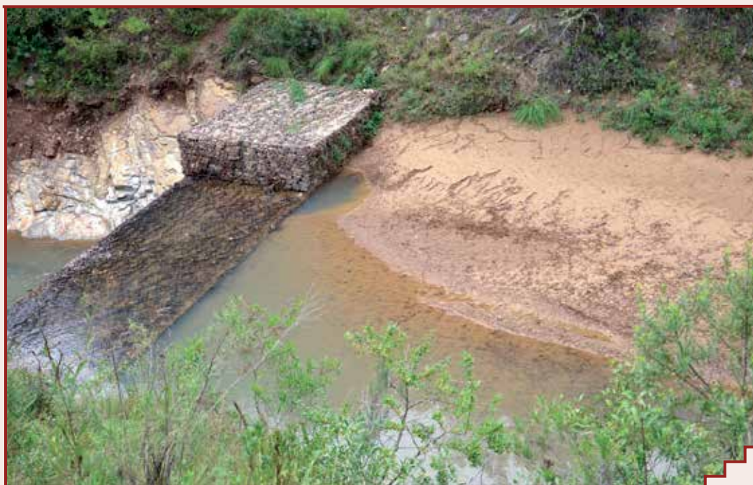
▲ Las obras físicas permiten la reducción de los sedimentos que pueden colmatarse un embalse o represa. En la foto una obra cerca de la represa Escalenas (Chuquisaca).
